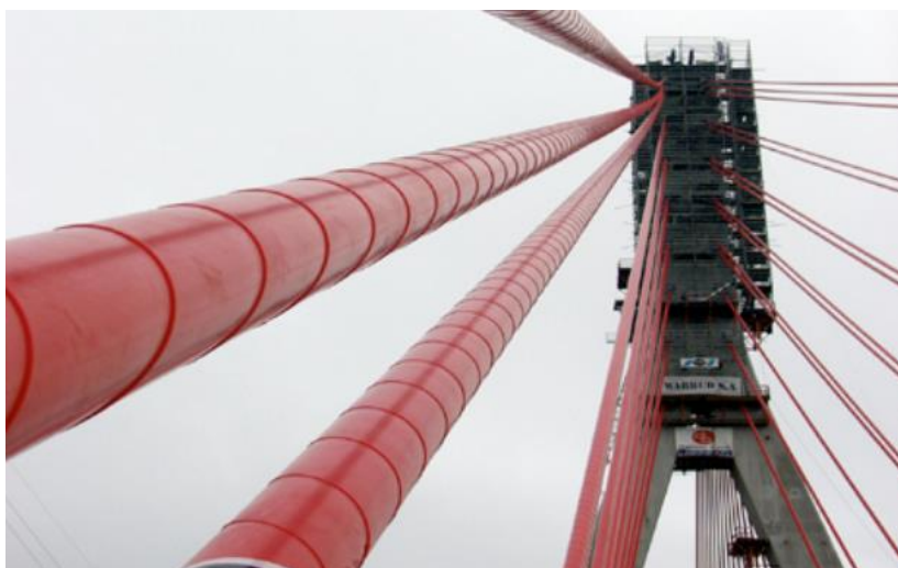
Figura 2.10 - Tubo Externo de Estais (FIB, 2002)
