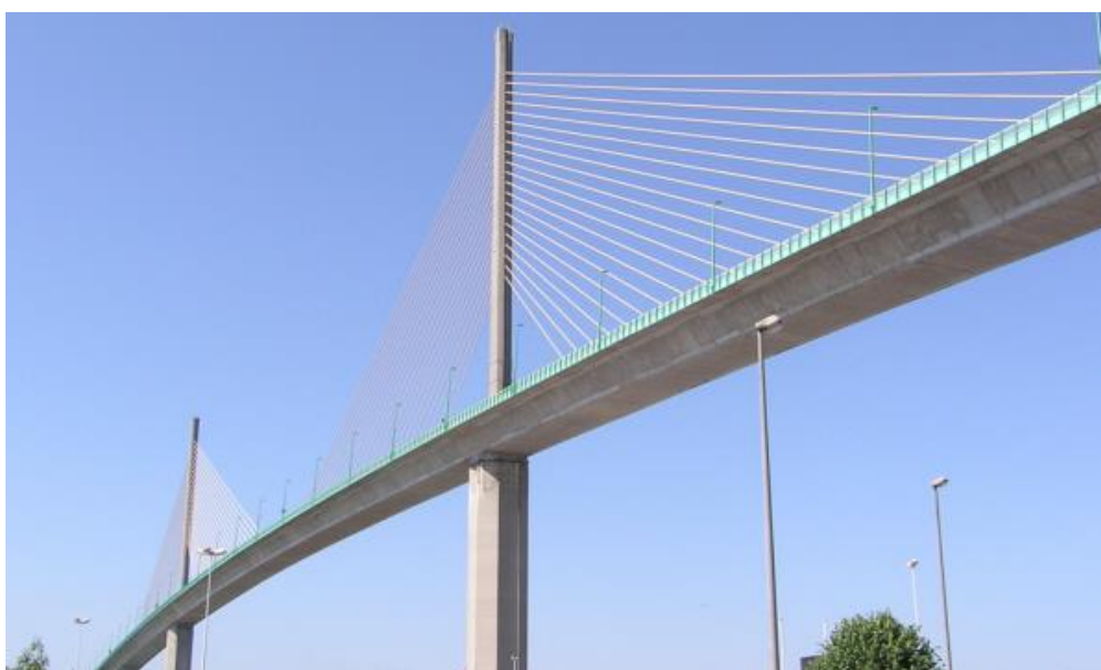
Figura 2.3 - Ponte de Brotonne sobre o Rio Sena, na França ( http://structurae.net/structures/brotonne-bridge )
