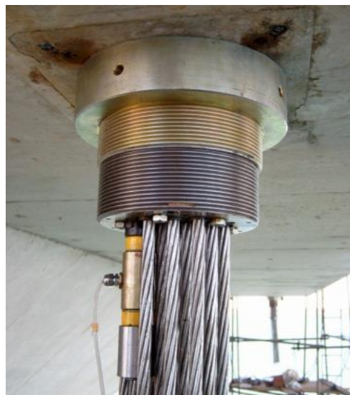
Figura 4.21 - Células de carga inseridas em uma das cordoalhas de cabos de estai (ONISHI, 2008).
