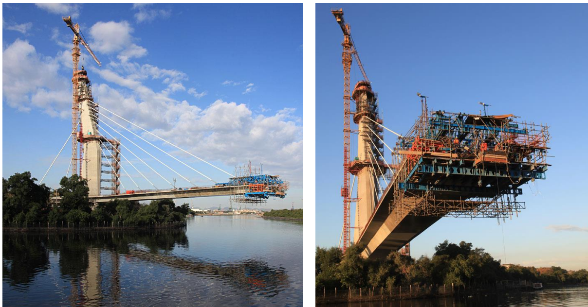
Figura 2.22 - Ponte do Saber, executada pelo método dos balanços sucessivos (vista das treliças de escoramento).
