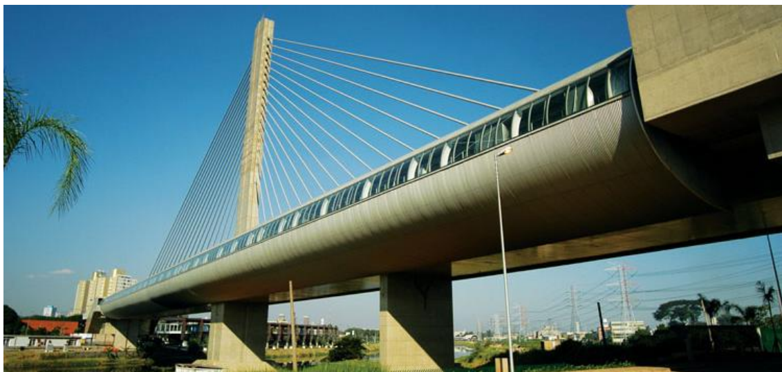
Figura 2.5 - Ponte Estação Metroviária Engenheiro Jamil Sabino na cidade de São Paulo ( http://www.enescil.com.br/index.php/br/estacao-de-metro-engenheiro-jamil-sabino )
