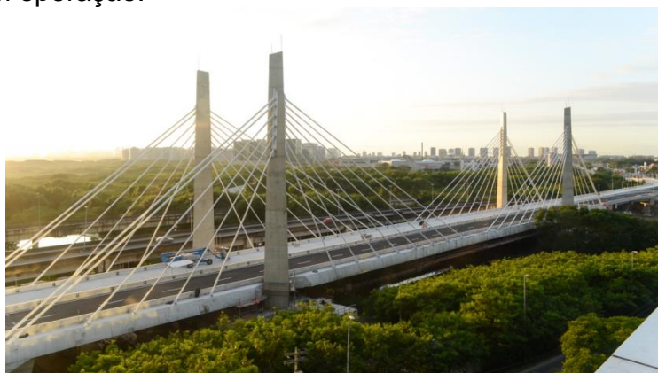
Figura 1 - Ponte Cardeal Dom Eugênio Sales ( http://www.demiranda.it/?portfolio=ponte-strallato-sullavenida-ayrton-senna-rio-de-janeiro-brasile )
